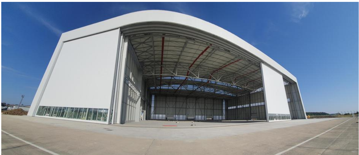
Figure 8 : Photographie de l'avancement du hangar au 15/09/2021
