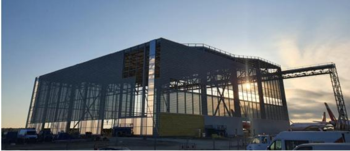
Figure 7 : Photographie de l'avancement du hangar au 07/04/2021
